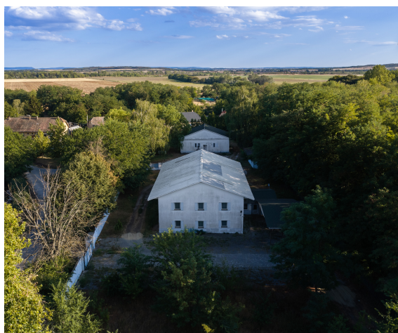
Az Esterházy Nagyvendégház felülnézetből
